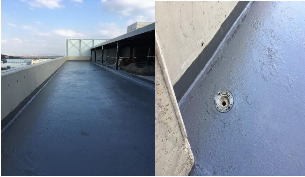
Resim 2. Poliüretan çatı yalıtımı
