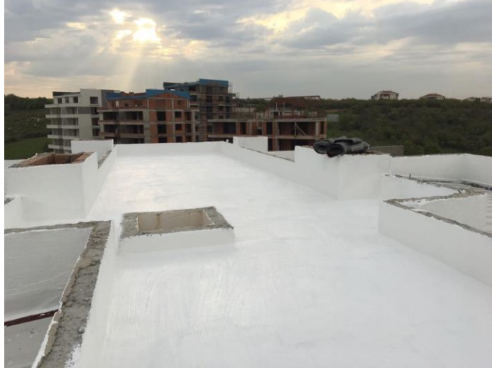
Şekil 1. Teras çatılarda kullanılan su yalıtım malzemeleri
